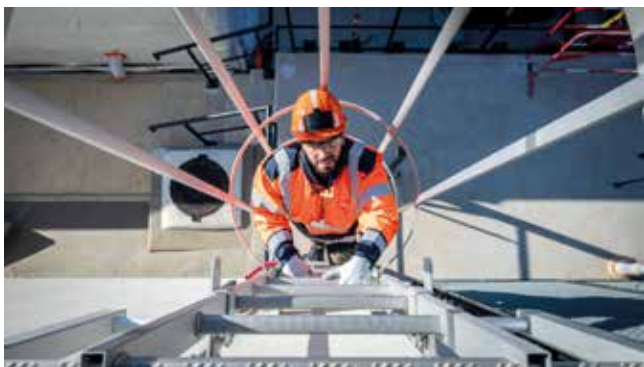
Ci-contre : Travaux sur la centrale nucléaire de Tricastin
