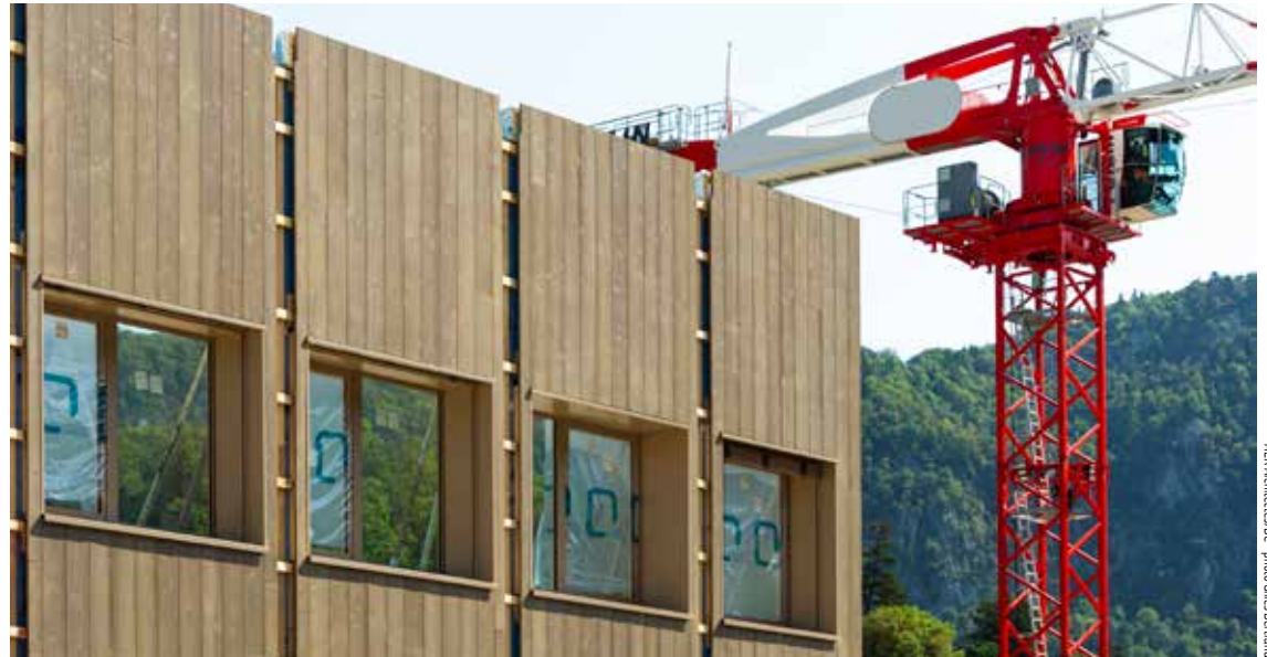
Chantier du collège Gaspard-Monge à Saint-Jeoire en Faucigny
