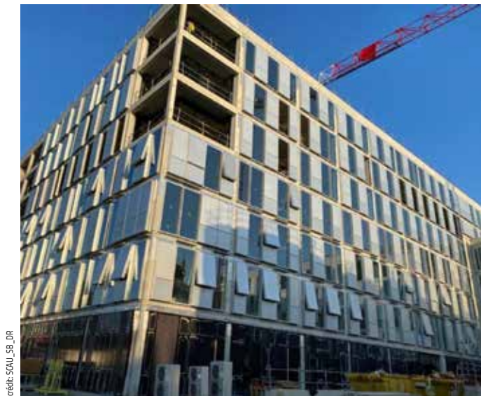
Réhabilitation lourde du siège de la CPAM à Bruges
