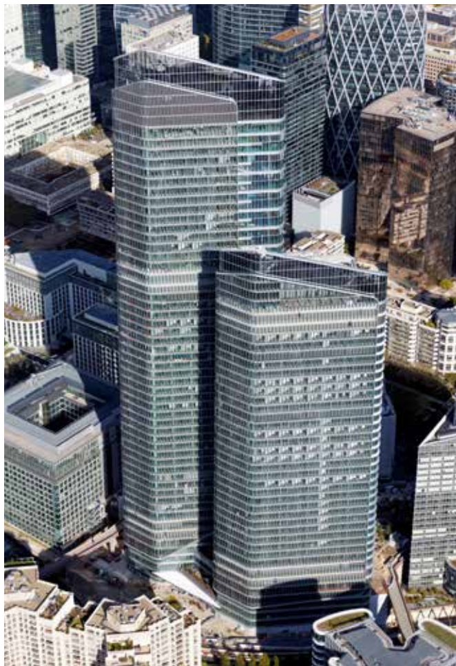
Chantier de The Link, dernière née des tours à la Défense
