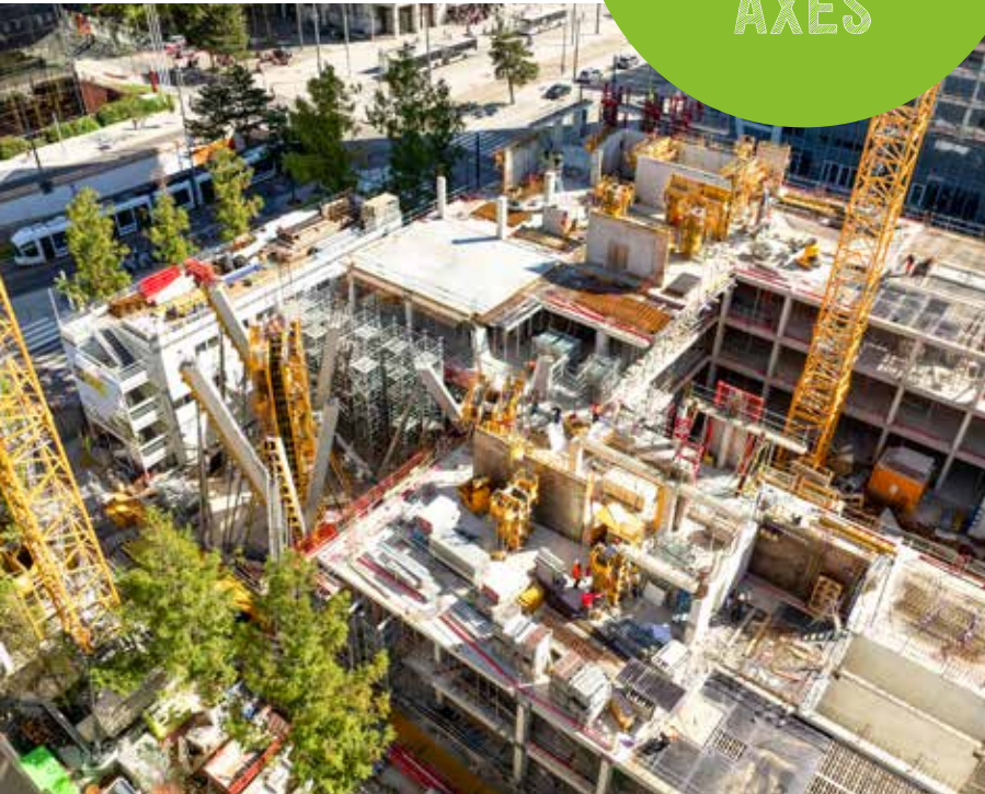
Chantier du projet Ki, immeuble mixte pour Cogedim à Lyon
