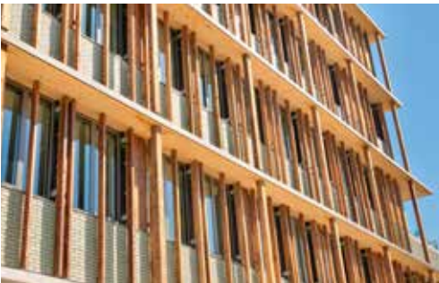
crédit Magnum/CCC, photo Eglisieur
