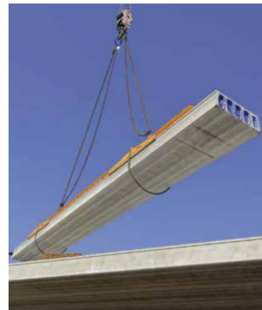
Opération de levage d'un élément plat
