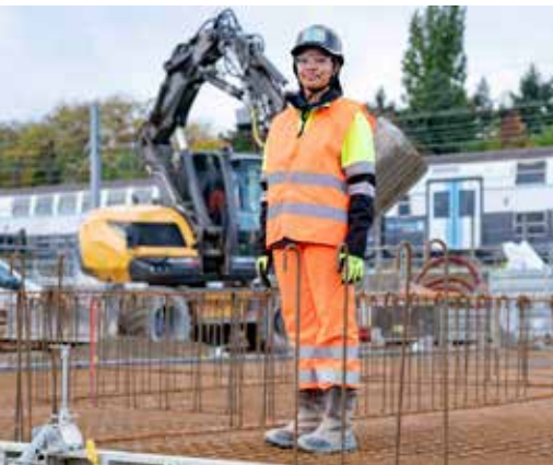
Chantier du Technicentre à Villeneuve Saint-Georges
