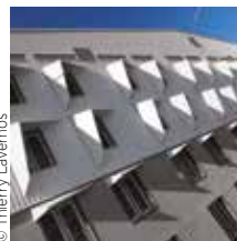
Architectes : Groupe 6 © Thierry Lavernos
