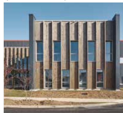
Architecte : Atelier M3 © Epailard Machado
