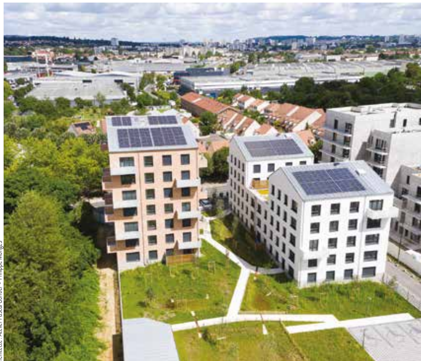
Architecte : Atelier Pascal Gontier © Philippe Monges
