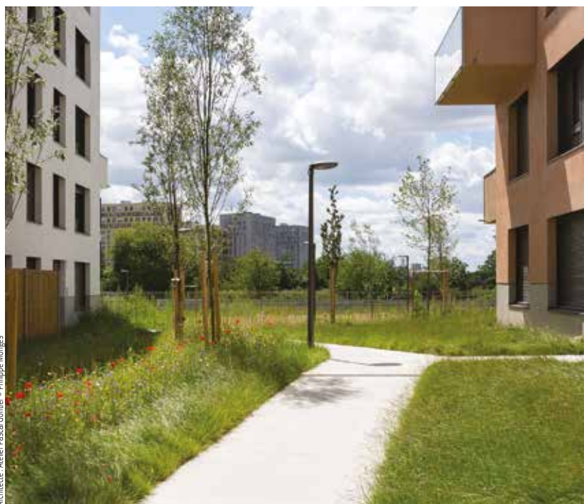
Architecte : Atelier Pascal Gontier © Philippe Monges
