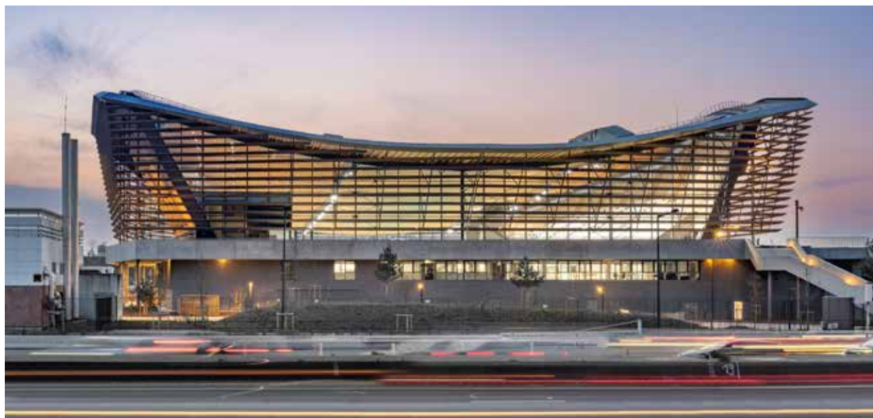
Centre aquatique olympique, Saint-Denis
