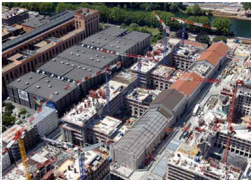
Chantier Universeine, Saint-Ouen
