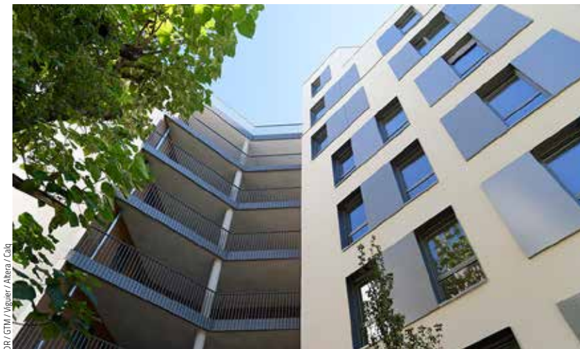
Transformation de bureaux en logements, Paris 14 e
