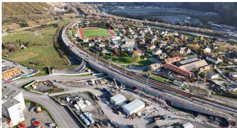
TELT, chantier du tunnel
