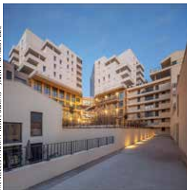
PRISM, logements, commerces et bureaux, Montpellier
