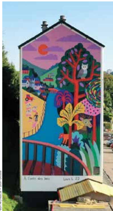
Réhabilitation de 206 logements sociaux, Barentin
