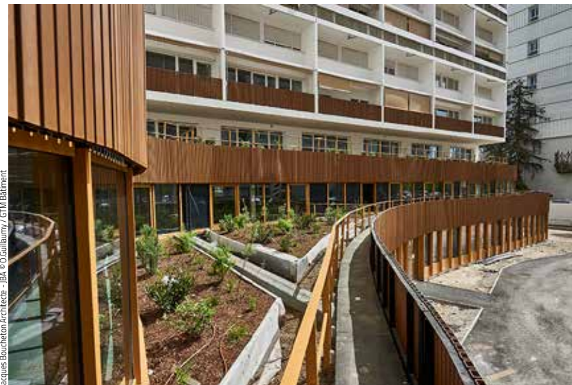
Les Aubiers, restructuration d'un ensemble urbain, dont 300 logements en site occupé, Bordeaux
