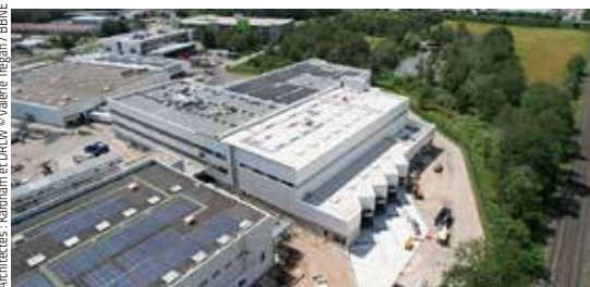
Merck, nouvelle unité de production « Single Use », bâtiment F
