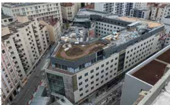
Chantier Next, Lyon
