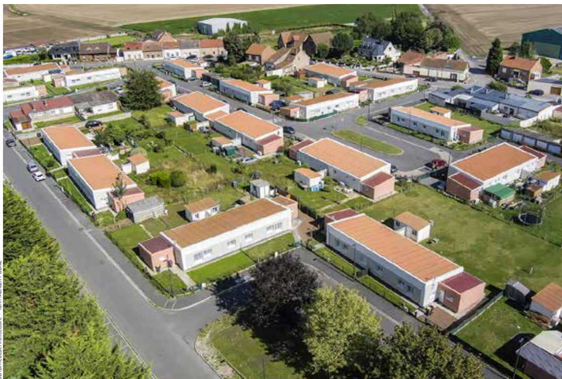
Rénovation de logements individuels « Les Camus », Lens
