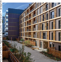
GTM Bâtiment Jaurès-Petit, construction et réhabilitation de logements, Paris 19e
