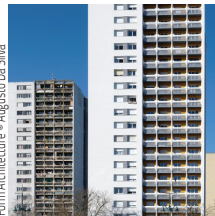
Bouygues Bâtiment Habitat social Réhabilitation de la Tour Neptune, Val Fourré, Mantes-la-Jolie
