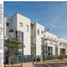
Léon Grosse Construction Rénovation de 191 logements, Clichy-sous-Bois
