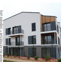
Léon Grosse Construction 92 logements, Taverny
