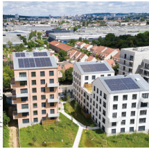
Architecte : Atelier Pascal Gombier © Philippe Monges
