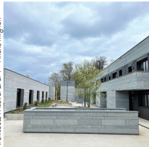
Architecte : Atelier 21/4 © Avelle Mignon
