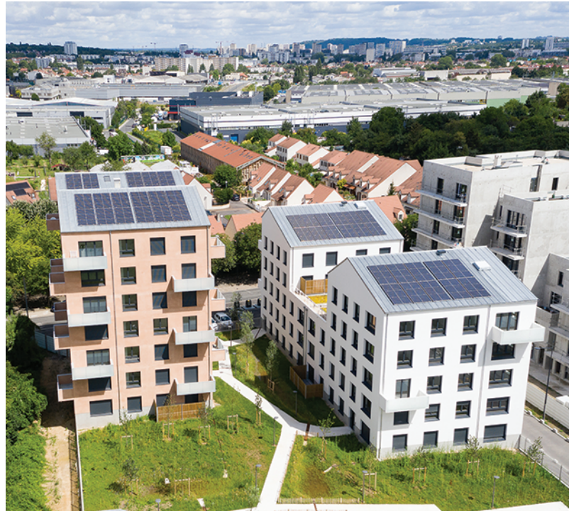
Architecte : Atelier Pascal Gontier © Philippe Monges
