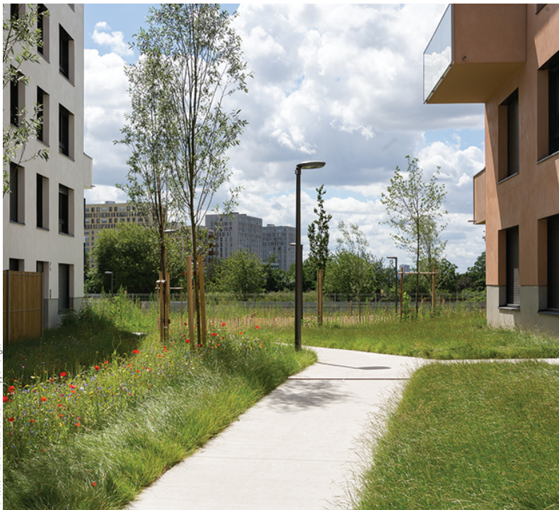
Architecte : Atelier Pascal Gontier © Philippe Monges
