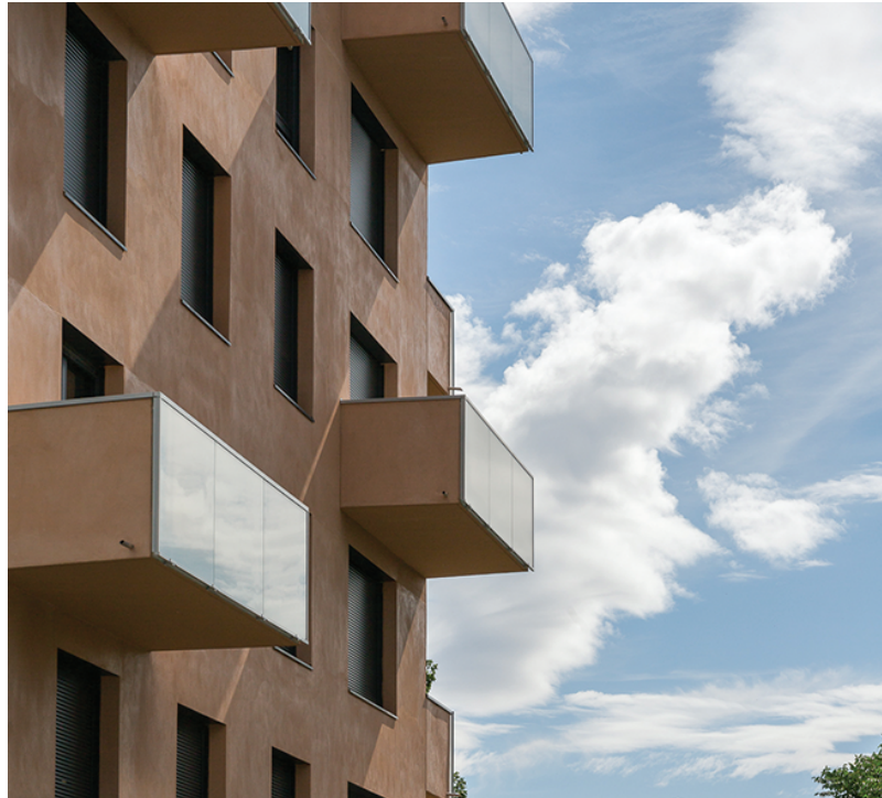
Architecte - Atelier Pascal Gontier © Philippe Monges
