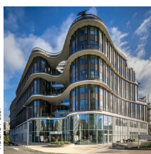
Architecte : Builders & Partners © Hélène Péter
