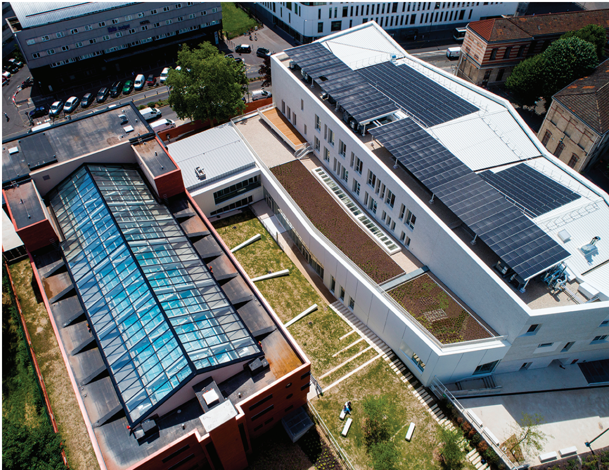
Architecte : Atelier Novembre et TNA © Alexandre Spira
