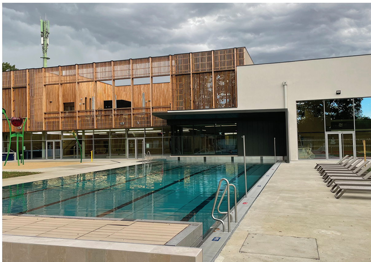
Groupement (Eiffage Construction Equipements, Coste Architecture, Patrick Tual, Clévia) © C. Lauté - SQY
