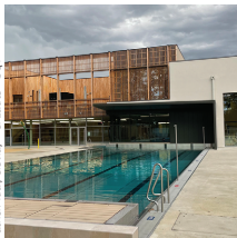
Groupement Eiffage Construction Equipements, Coste Architecture, Patrick Nial, Clément C. Laillet - SCV
