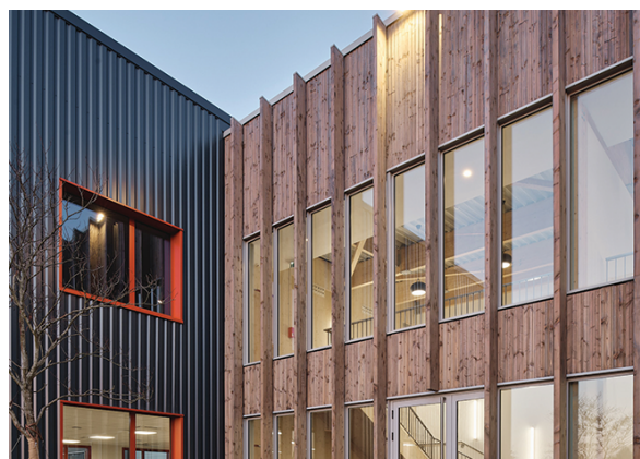
Architecte : Atelier M3 © Epailard Machado
