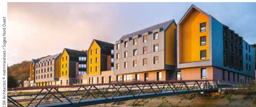
Ehpad Maurice Collet à Caudebec-en-Caux
