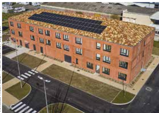
Campo/Bâtir, logements pour le personnel des armées.
