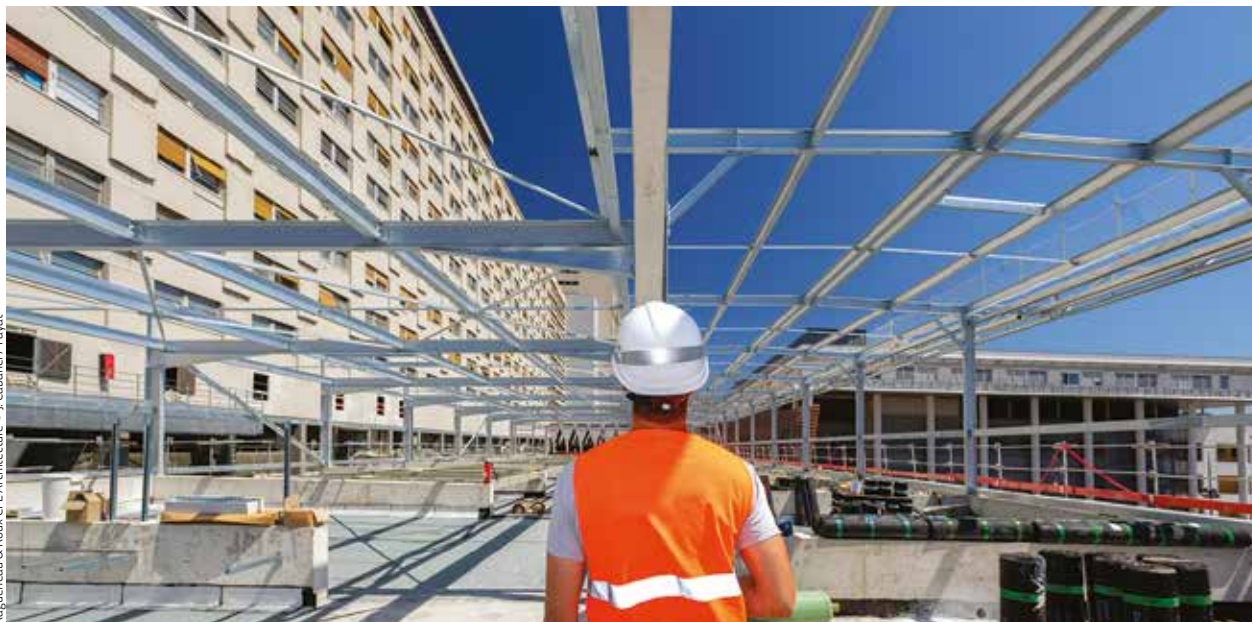
Biogénopole de Marseille (restructuration lourde en site occupé) pour l'AP-HM.
