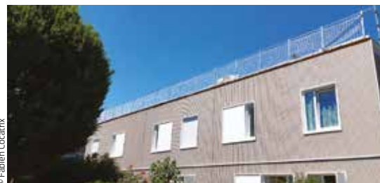
Réhabilitation de logements à Wattrelos.
