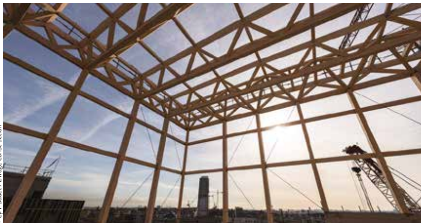
Chantier du village olympique à Saint-Ouen le 30 mars 2023.
