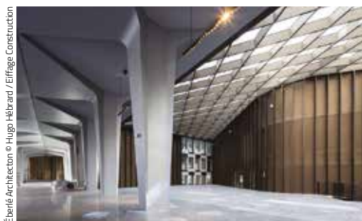
L1VE, restructuration de bureaux, avenue de la Grande Armée à Paris.
