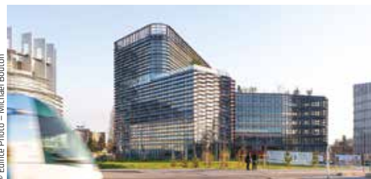
Osmose, vue d'ensemble extérieure.
