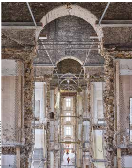
Restructuration de la Caserne Thiry à Nancy pour la future cité administrative.
