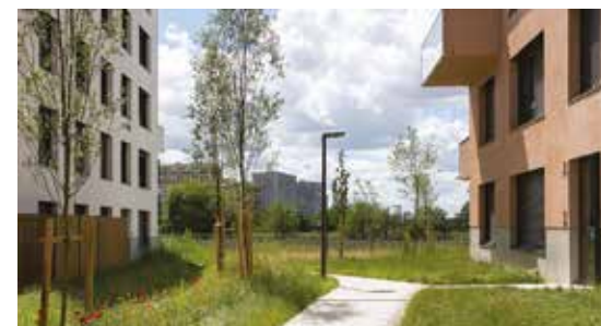
Architecte : Atelier Pascal Gontier © Philippe Monges
