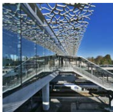
Demathieu Bard Gare de Nantes
