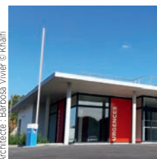
Architecte : Barbosa Vivier © Khalifi
