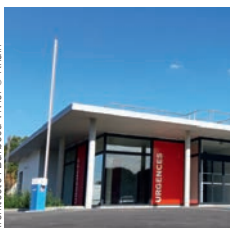
Architecte : Barbosa Vivier © Khalifi
