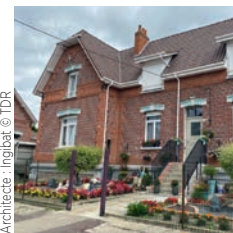
Architecte : Ingibar © TDR
