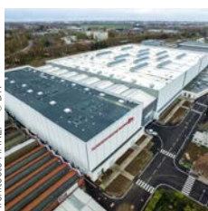
Architecte : IAREP © DR
