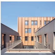
Bouygues Bâtiment Nord-Est Centre de formation aux métiers de l'industrie et de la métallurgie à Mulhouse
