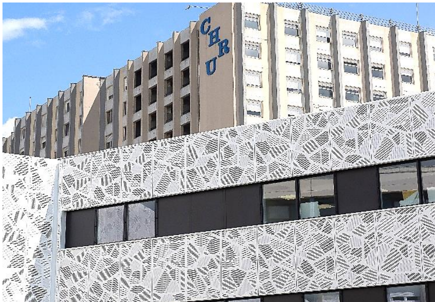
Architectes : Guillaume Delemazure © Crédit photo - Luc Boeely
