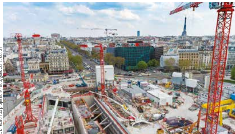
Chantier Éole, porte Maillot, Paris
