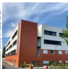
Architectes : SANAE © Pascal Roman
