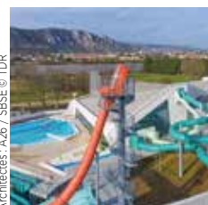
Architectes : A26 / SBSE © TDR
