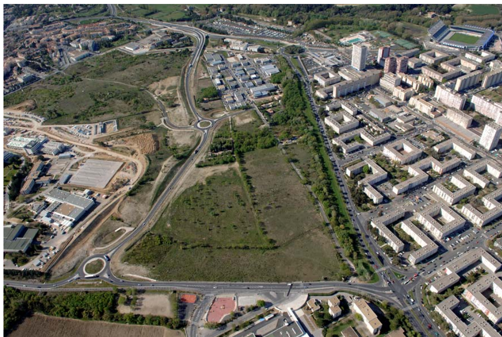
Photo aérienne _ ZAC PIERRES VIVES
