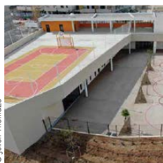
Giraud Construction Groupe scolaire Jean d'Ormesson Saint-Jean-de-Védas
