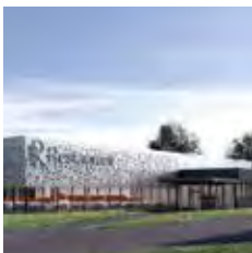
Architecte : ATALUB - © TDR
