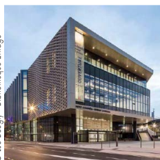
Eiffage Construction Centre des congrès Robert Schuman Metz
