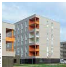
Bouygues Bâtiment Nord Est Îlot D5, Micheville
