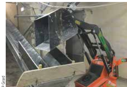
Mécanisation de travaux de curage et évacuation de gravats.
