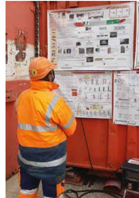
Affichage sur chantier des points clés de contrôle.
