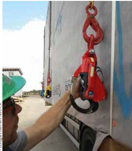
Ces crochets sont connectés à une télécommande permettant de les ouvrir à distance.
