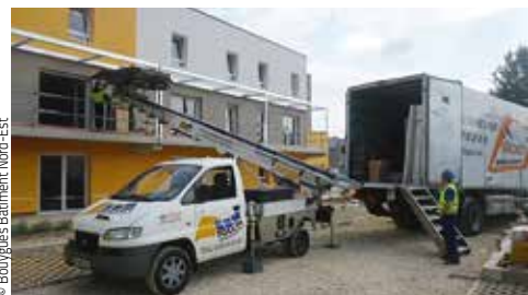
Approvisionnement et stockage dans les logements.
