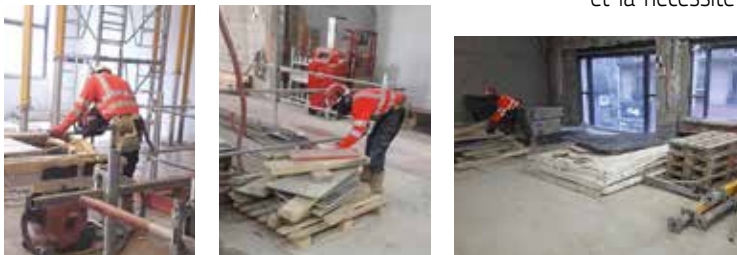
Gestion du matériel : découpe des matériaux au 3 e étage puis recherche des matériaux / matériels.
