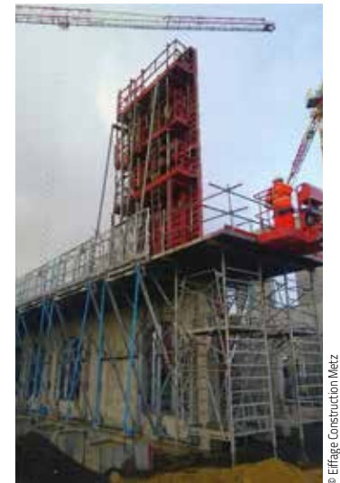
Remplacement tour par PTE contreventées.
