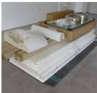
Démarrage après les sols souples et peinture.
