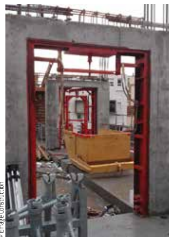
Conception d'un outil permettant de remplacer les mannequins de porte traditionnels.
