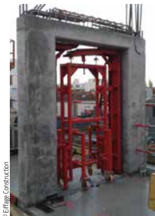
Conception d'un outil permettant de remplacer les mannequins de porte traditionnels.
