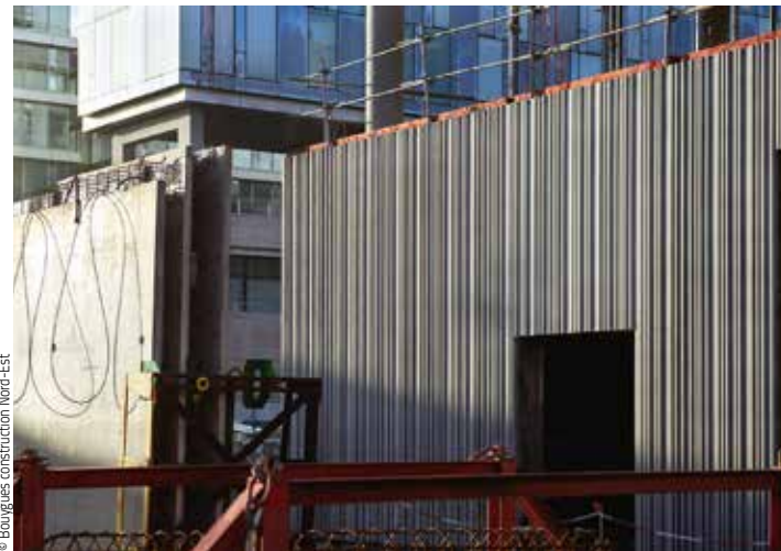
La préfabrication, qui représente une part non négligeable des remontées d'incidents, a fait l'objet d'une démarche de standardisation depuis 2017.
