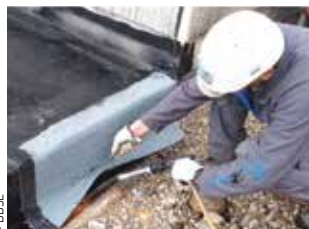
Diminution du risque incendie lors des opérations d'étanchéité par l'utilisation d'un matériel à extinction automatique.
