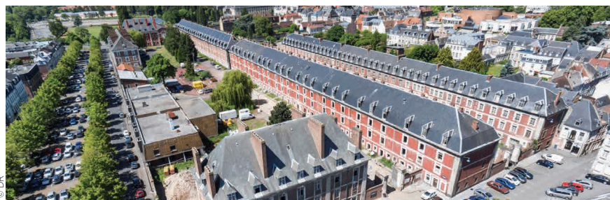
Chantier de réhabilitation de la caserne Schramm à Arras, qui a reçu le Trophée de bronze du Concours Prévention-santé-sécurité d'EGF.BTP architecte : Luc-Emmanuel Lombard (Cadence)
