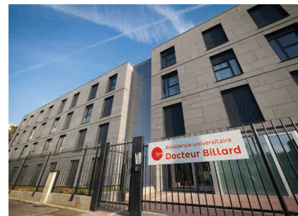
LCR Architectes © Jean Drieux
