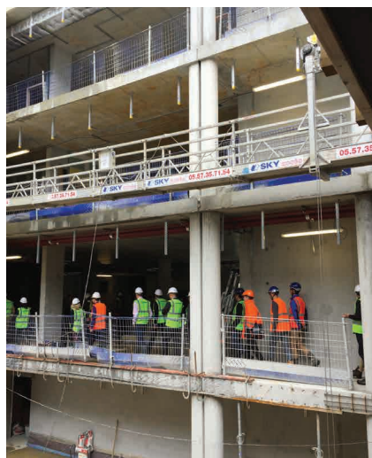
Visite de chantier de l'hôpital de Libourne.
