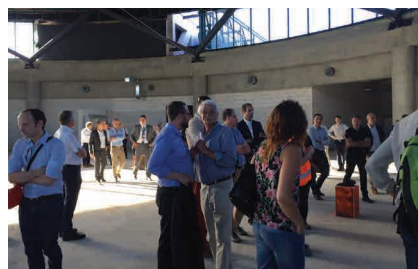
Visite du chantier du terminal 1 à l'aéroport Saint-Exupéry.
