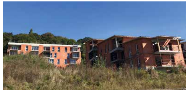
Visite du chantier Gotham à Harfleur (Gagneraud).
