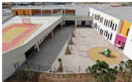
Architecte : Imagine © Giraud
