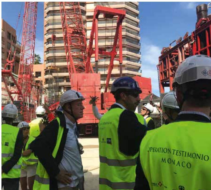
Visite du chantier Testimonio II par VINCI Construction.
