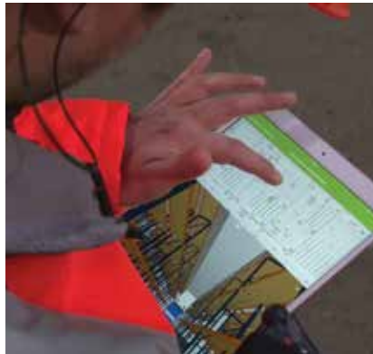
L'utilisation de la maquette numérique sur un chantier pour effectuer les contrôles qualité.
