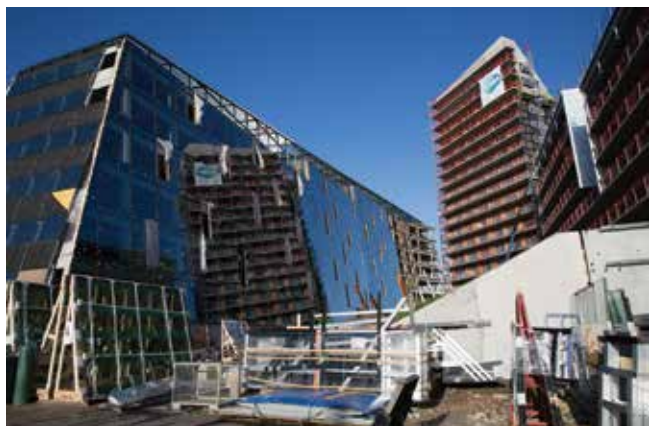
La délégation a présenté ses vœux sur le chantier Ekla à Lille.
