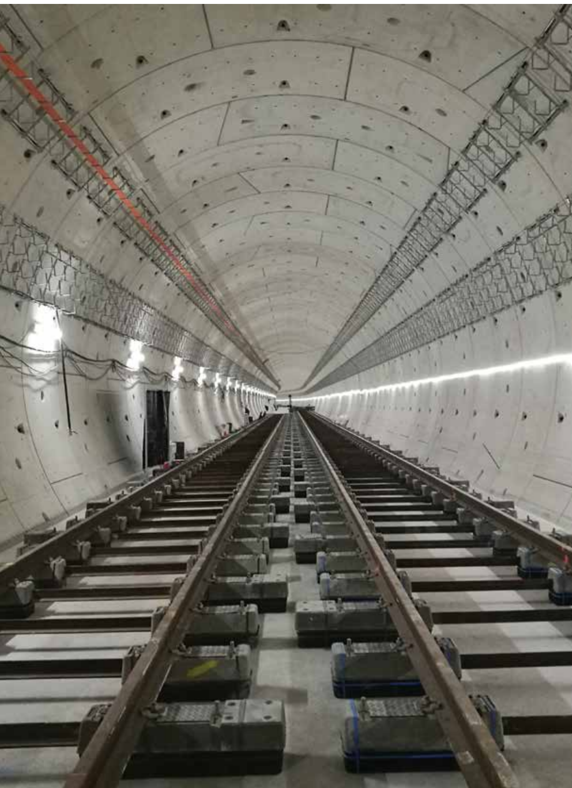
Extension de la ligne 14 du métro, Paris.
