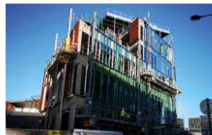
Vœux 2019 : visite du chantier swam (Rabot Dutilleul).
