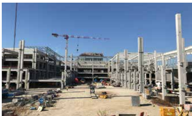
Visite du chantier Ikéa, Vénissieux
