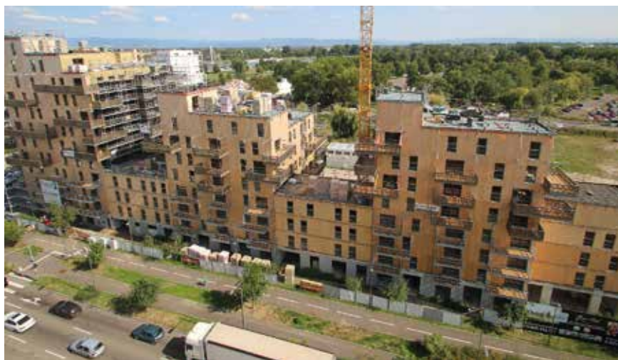
Visite du chantier îlot bois-Sensations.
