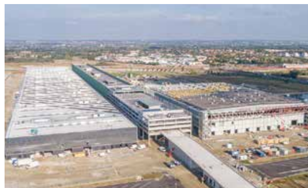
Un chantier emblématique en Midi-Pyrénées : le parc des expositions, Toulouse.
