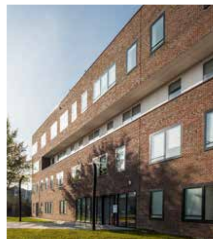
© R-P Ribière Réhabilitation en site occupé des bureaux ERDF, Amiens.
