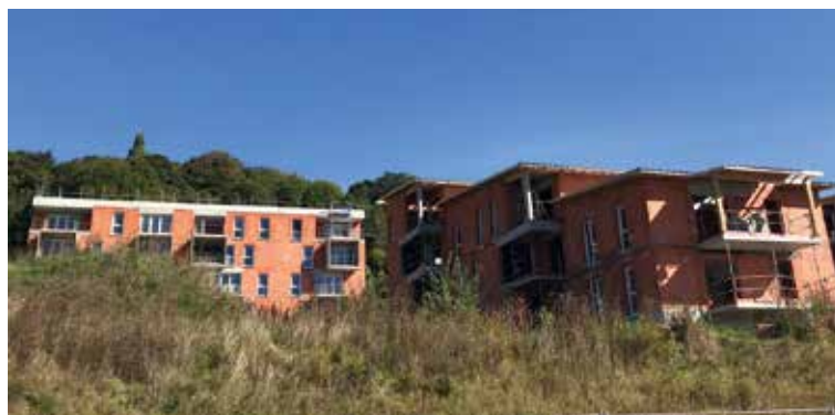
Visite du chantier Gotham à Harfleur (Gagneraud).
