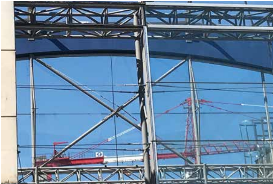
La gare de Nantes en chantier.
