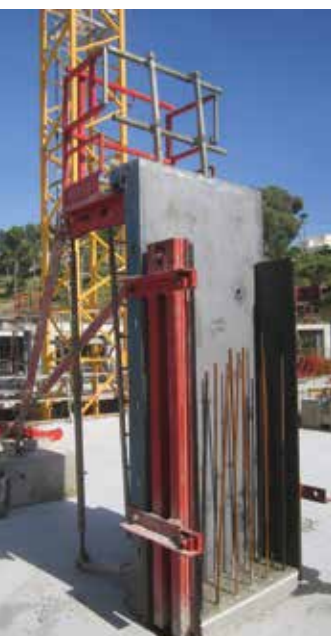
Pose des arrêts d'about des poteaux.
