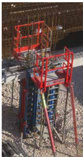
Bétonnage du poteau.
