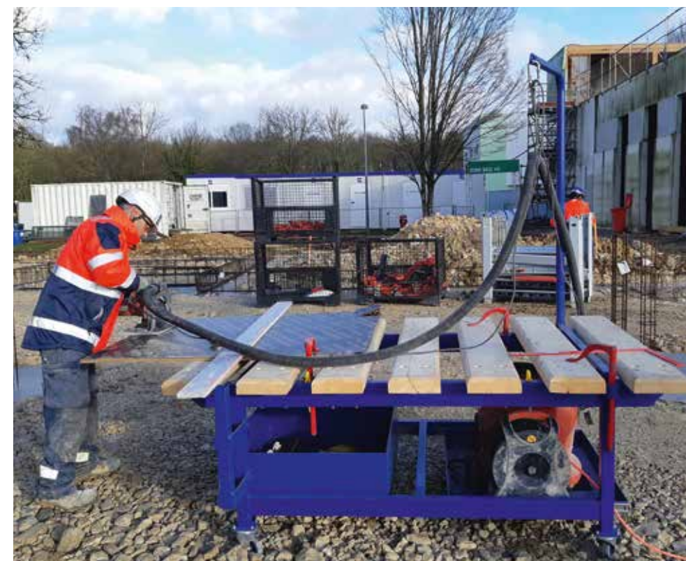
L'établi « 5S sur site ».
