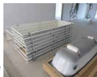
Après le ragréage et avant le démarrage du lot plâtrerie.
