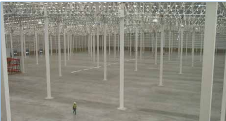
Exemple d'un dallage précontraint de 28.000 m 2 sans joint de dilatation – Chili
