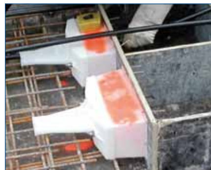
Exemple d'ancrages 4 T155 fixés sur un coffrage d'about
