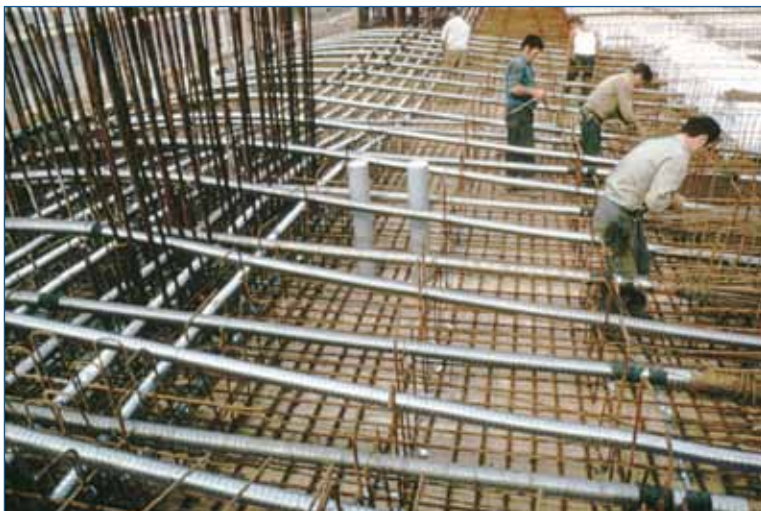
Gainage d'une dalle de transfert
