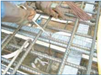
Conduit gaine rectangulaire métallique 4 torons
