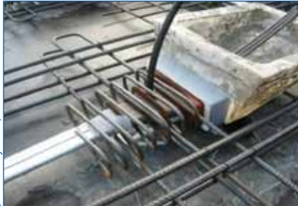
Accessoire de coffrage en partie courante
