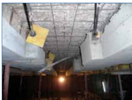
Renforcement après incendie d'un plancher de parking – câbles monotorons BBR CMM
