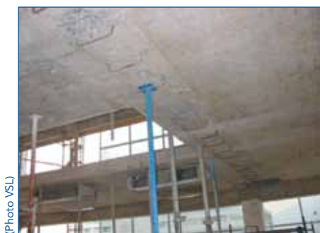
Création d'ouvertures dans le cas d'une précontrainte adhérente avec renforcement par épaissement localisé de la dalle
