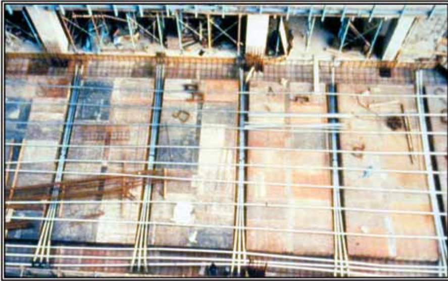
Vue d'un plancher type poutre-dalle en cours de réalisation
