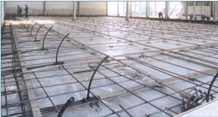
Exemple d'un dallage précontraint en cours de réalisation
