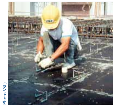
Exemple de mise en place de chaises support
