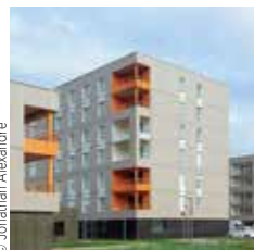
Bouygues Bâtiment Nord Est Ilot D5, Micheville
