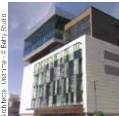
Demathieu Bard Plateforme photographique du CEA de Grenoble
