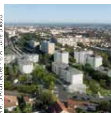
Bouygues Bâtiment Centre Sud Ouest Résidence La Gloire, Toulouse
