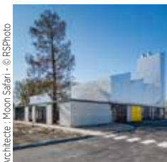
GCC Aquitaine Chaudière de Plaine Garonne Énergie, Bordeaux
