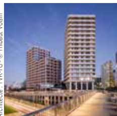
Bouygues Bâtiment Île-de-France Lot 08, ZAC des Batignolles, Paris
