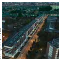
Eiffage Construction Nord Pas-de-Calais Résidence Thalès, Tourcoing
