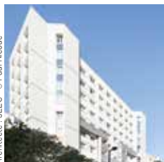
Bouygues Bâtiment Île-de-France Bâti- ments réhabilités Résidence Panoiaux/Amandiers Paris 20 e
