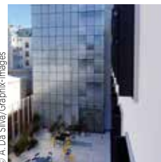
GTM Bâtiment Charles V, Paris
