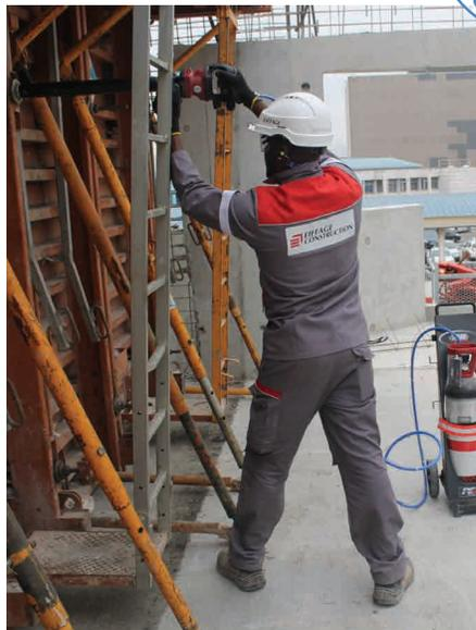
Système de serrage et desserrage pour écrous des tiges d'entretoises 4G.
