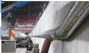
Partie fixe du système centralisé d'aspiration des fumées des grues mobiles.
