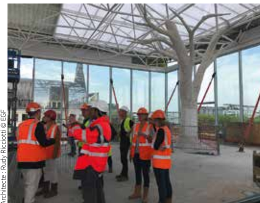
Visite du chantier de la gare de Nantes avec des clients.
