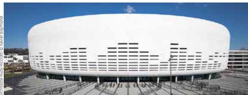
Arkéa Arena, Floirac, réalisé en CREM
