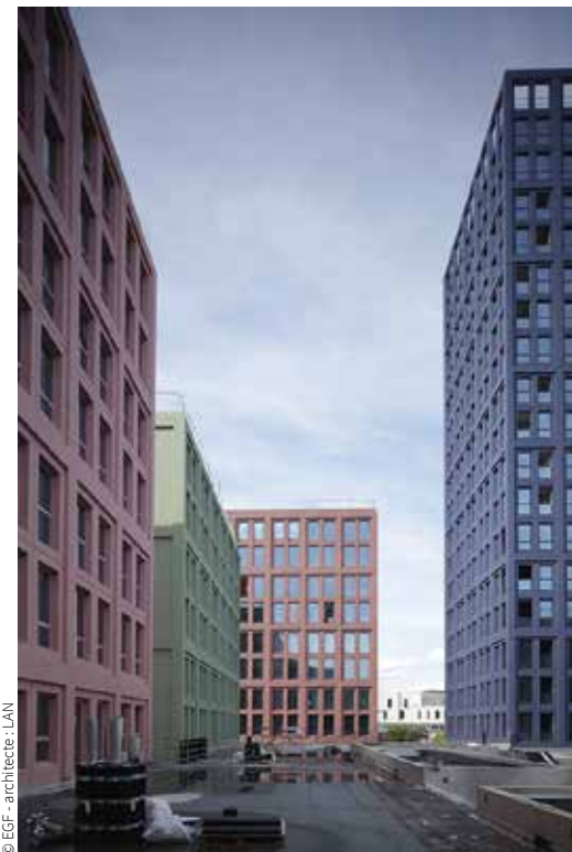
Visite clients sur le chantier strasbourgeois de NoListra, réalisé par Urban Dumez.
