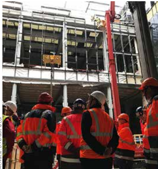
Visite du chantier de rénovation de la poste du Louvre (Bouygues Bâtiment)
