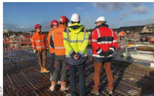
Visite du chantier « in City », Caen
