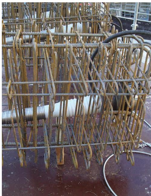
Fig. 8 • Exemples de câbles multi torons
