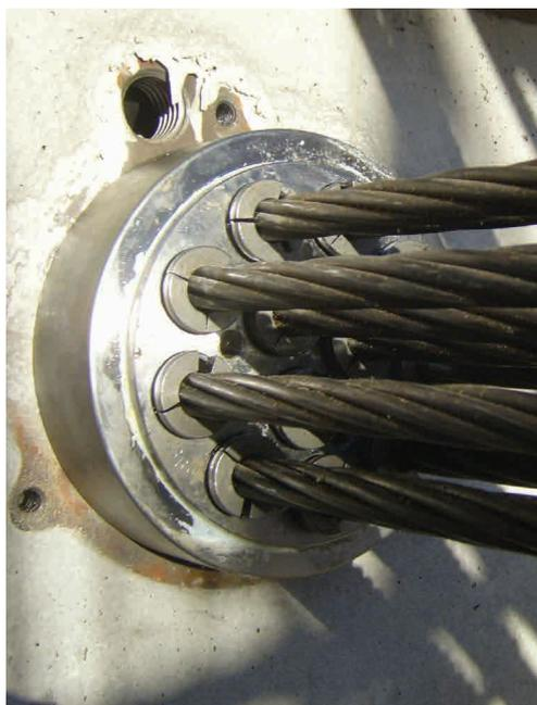
Le cas élémentaire est constitué du monotoron (Fig. 9) gainé graissé unique dans sa gaine. Diverses combinaisons regroupent plusieurs torons par câble (Fig. 8). Ces câbles constitués de plusieurs torons sont enfilés dans leur gaine après bétonnage.
